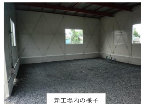
新工場内の様子
